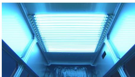
荷物コンベア用装置(内部)
